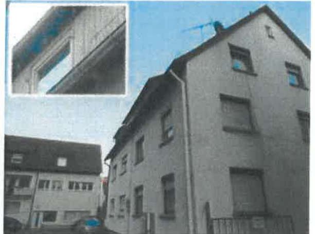
Abb. 8: Blick auf das nördliche Wohngebäude ohne Nischen, Spalten oder Öffnungen.
