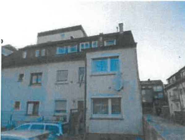
Abb. 9: Blick auf das nördliche Wohngebäude ohne Nischen, Spalten oder Öffnungen.
