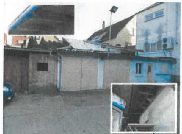
Abb. 12: Blick auf den nördlichen angebauten Schuppen mit Öffnung.
