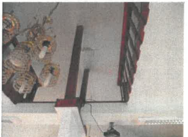
Abb. 6: Die Decke des Gebetsraumes reicht ohne Zwischenraum direkt bis unter den Dachstuhl.
