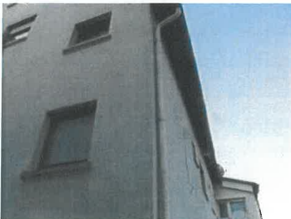
Abb. 11: Blick auf das nördliche Wohngebäude ohne Nischen, Spalten oder Öffnungen.
