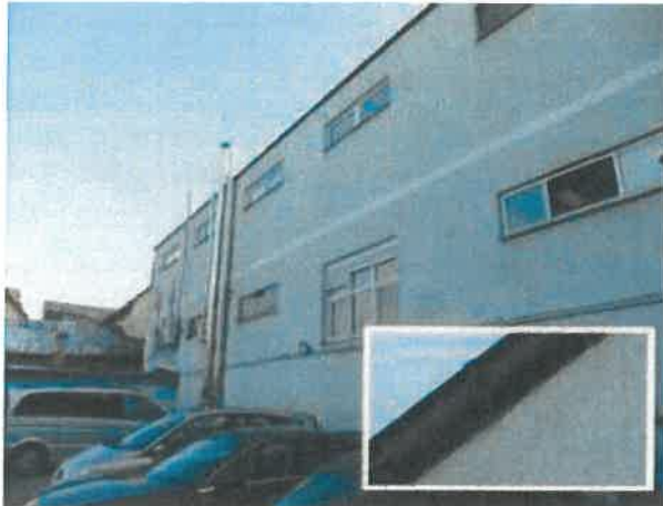
Abb. 7: Rückwärtiger Teil (Nordseite) des Gebäudes mit Gebetsraum ohne Nischen.
