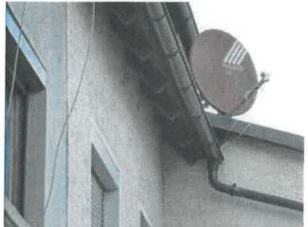
Abb. 10: Blick auf das nördliche Wohngebäude ohne Nischen, Spalten oder Öffnungen.
